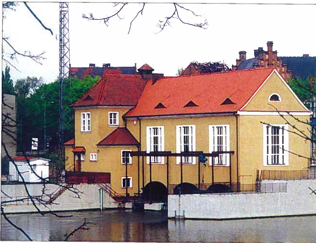
Elektrownia wodna Żagań I
