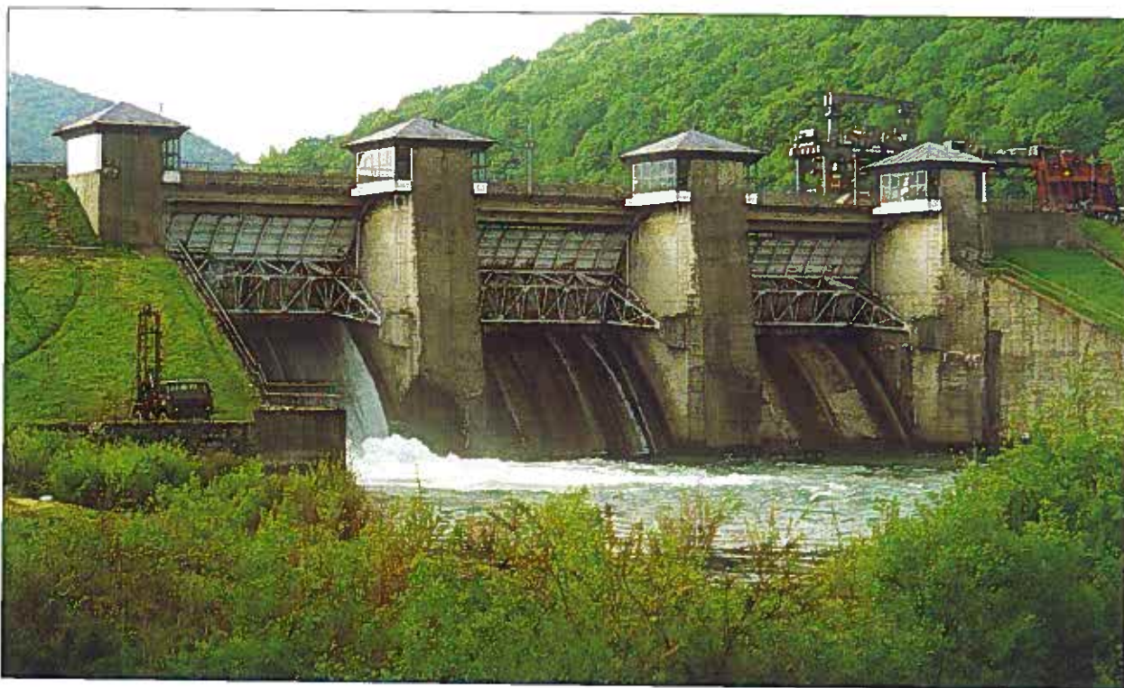
Elektrownia Wodna Myczkowice – jaz
