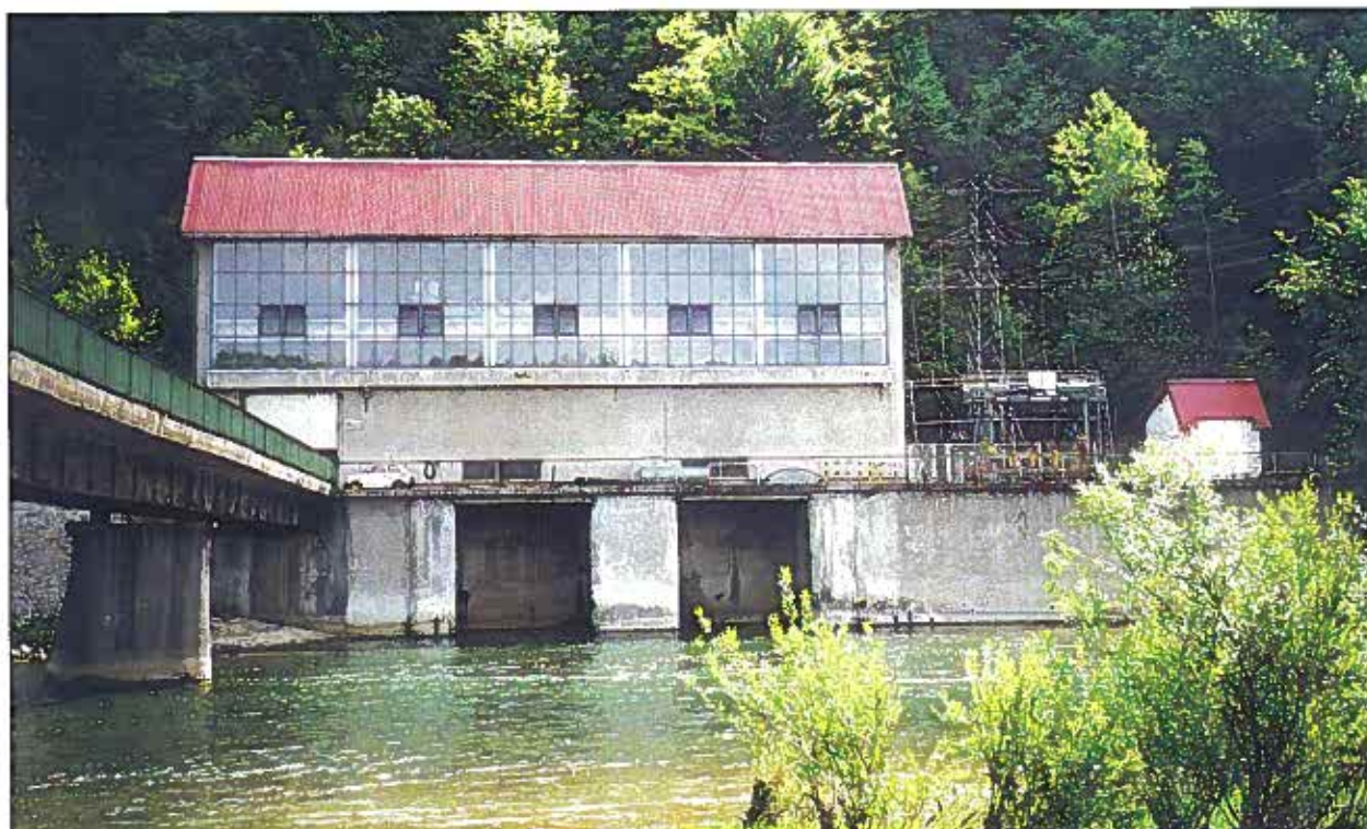
Elektrownia wodna Myczkowice
