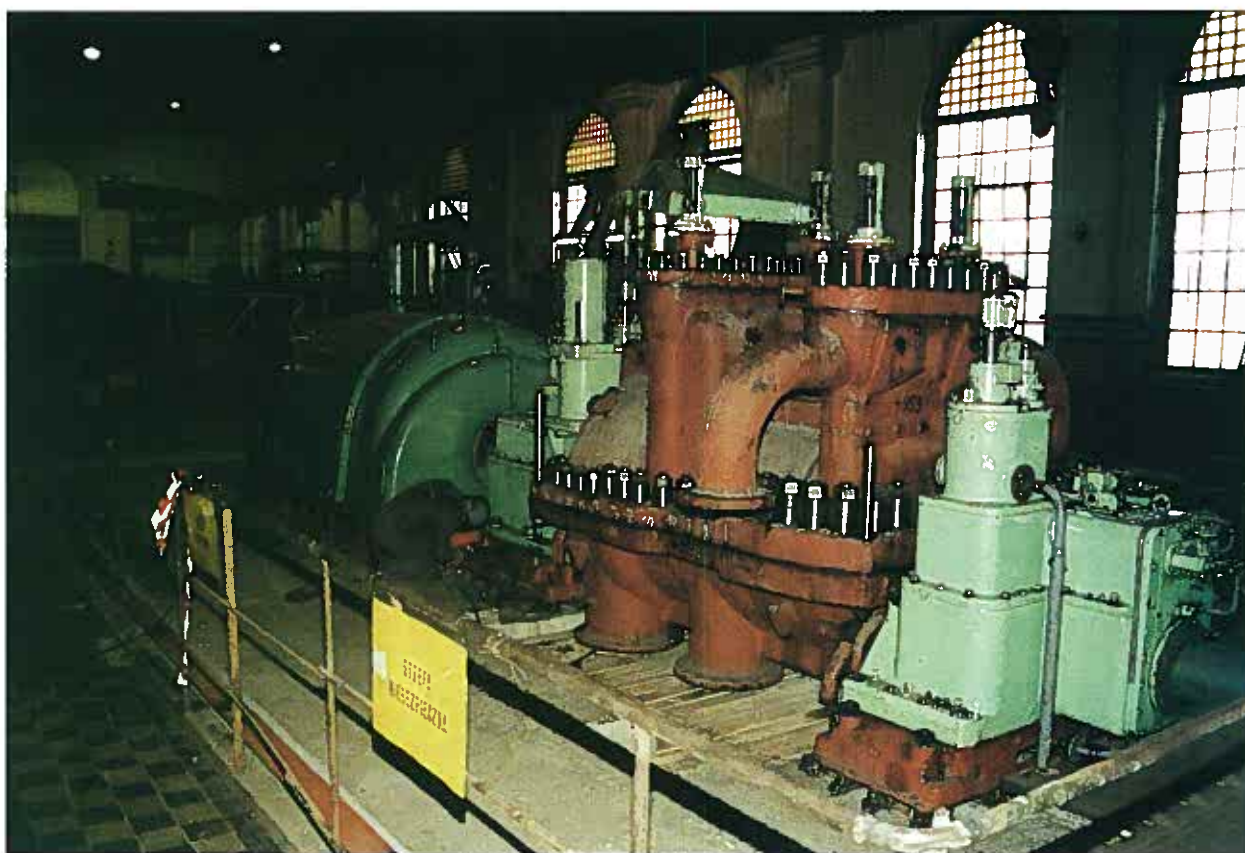
Turbozespółt upustowo-przeciwprężny PR-10 w trakcie montażu w „Elektrociepłowni Marcel” Sp. z o.o.
