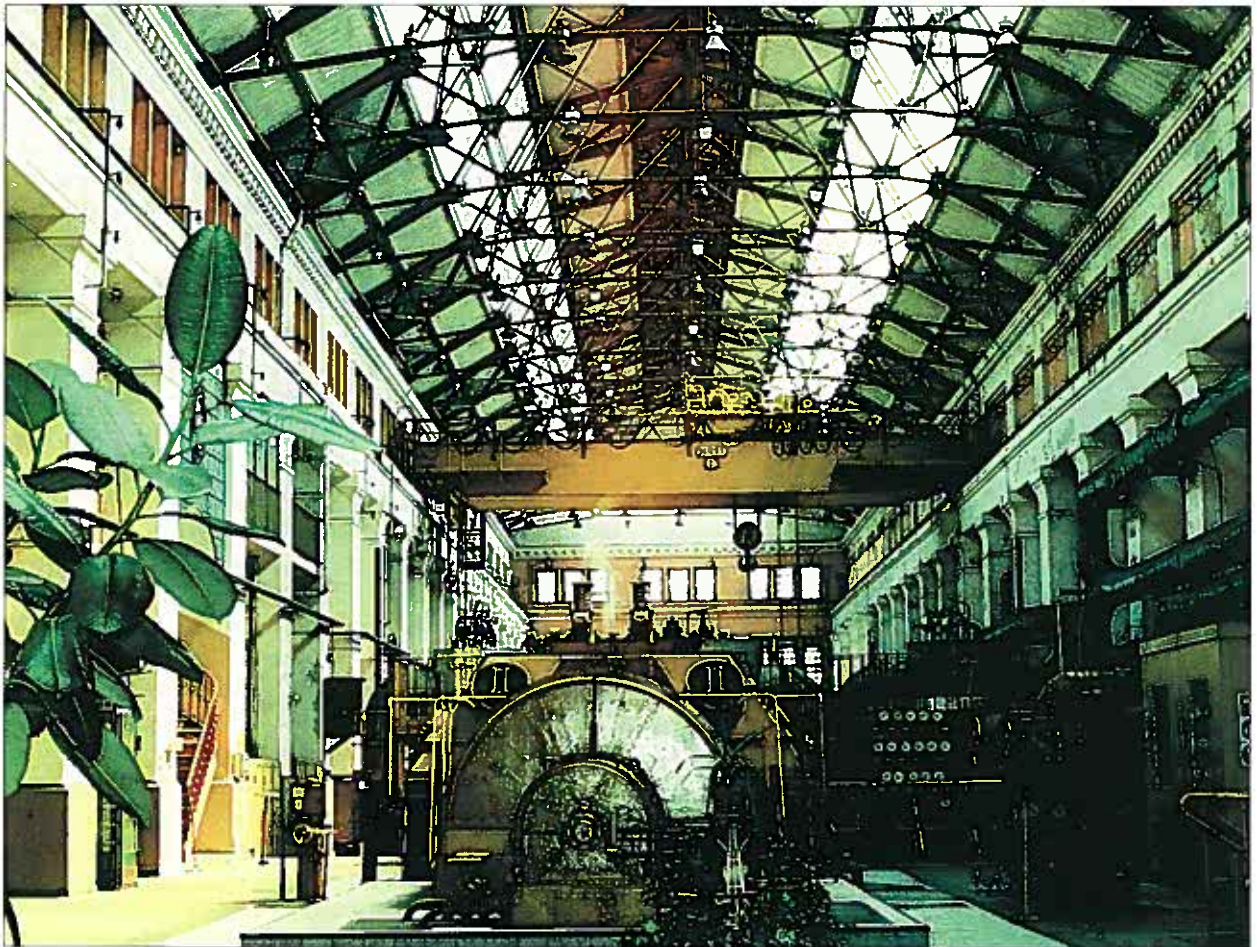
Hala maszyn Elektrociepłowni Zabrze SA
