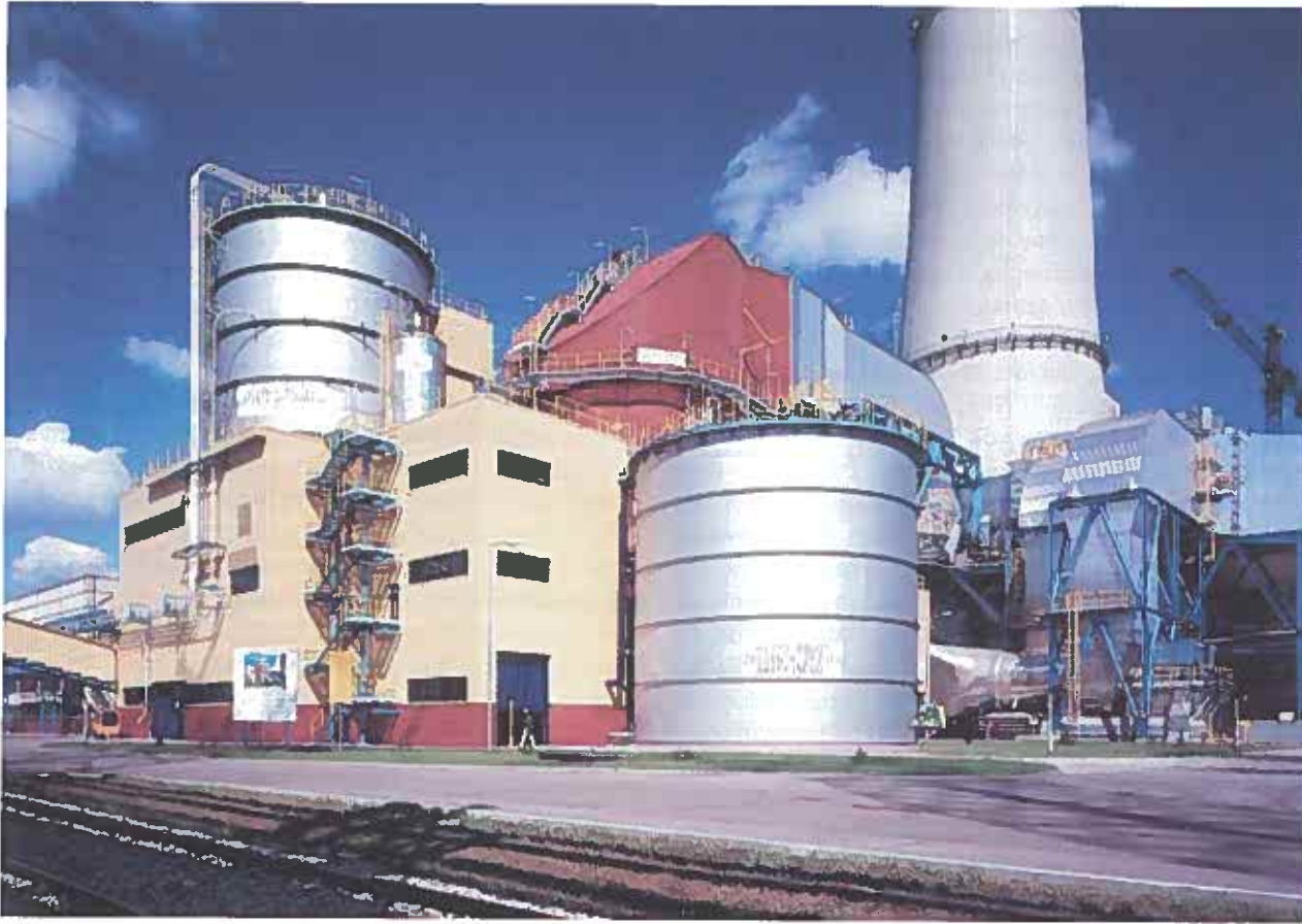
Elektrownia Kozienice - IOS
