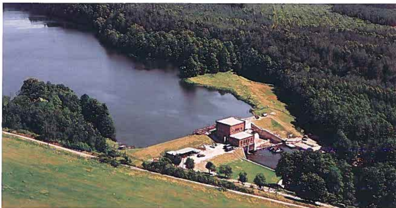
Energetyka Poznańska – Zakład Elektrowni Wodnych Sp. z o.o. Jastrowie
