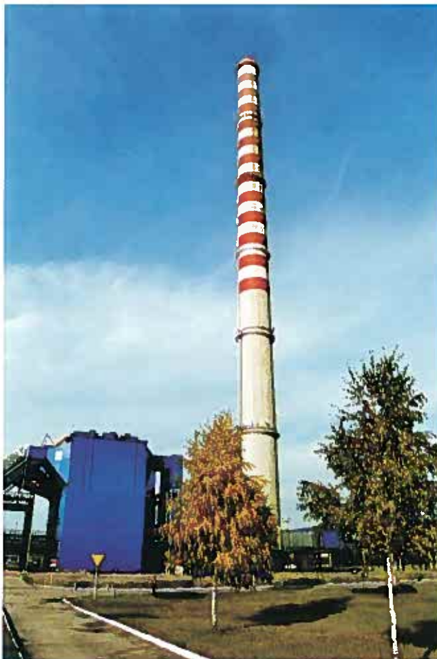
Elektrociepłownia Toruń – widok na elektrofiltr z kominem
