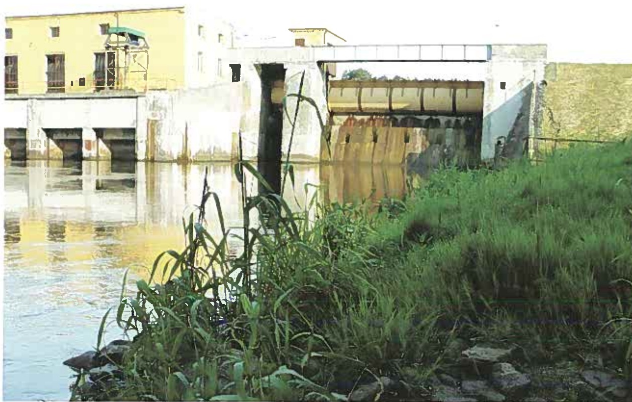
Elektrownia Wodna Smukała
