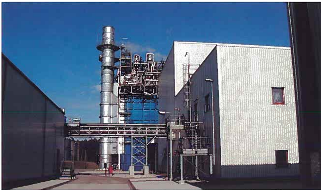
Elektrociepłownia Nowa Sarzyna Sp. z o.o.
