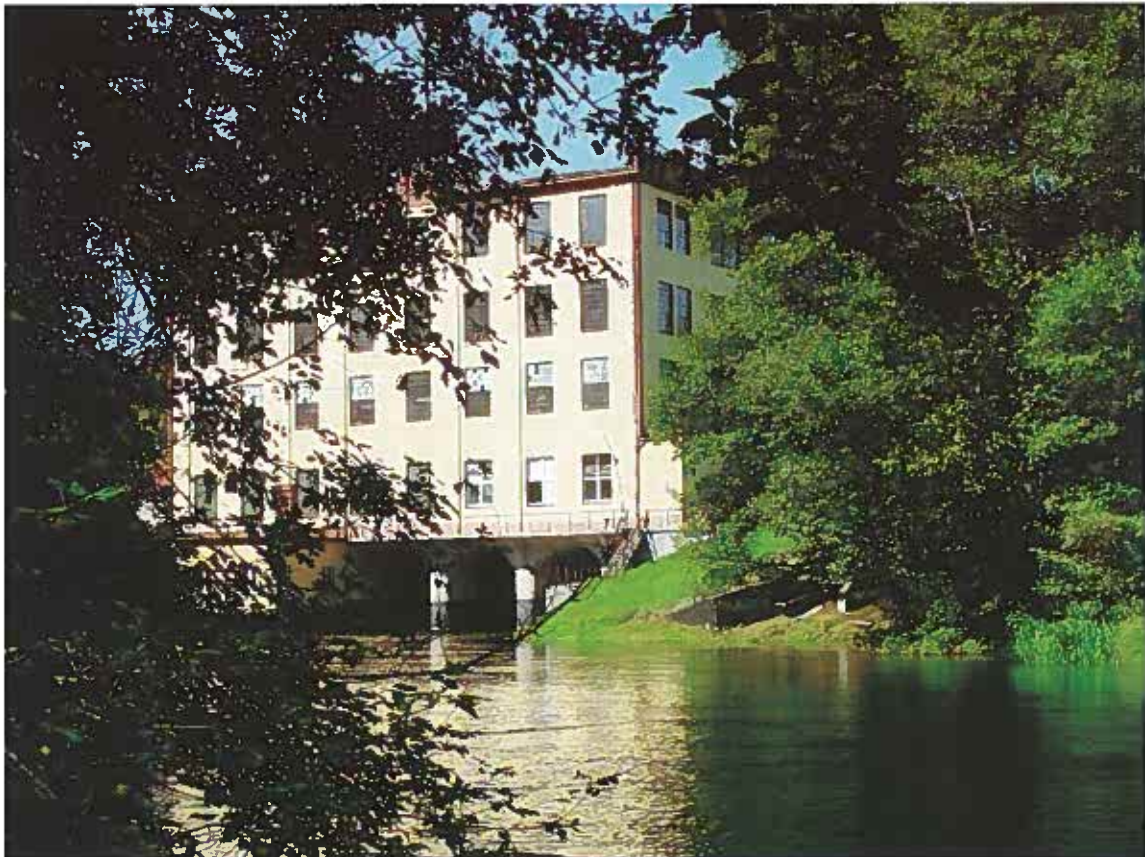
Elektrownia wodna Gródek
