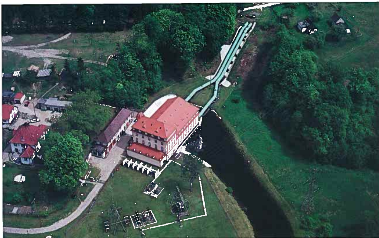
Elektrownia wodna Gałężnia (EW ENWOD)
