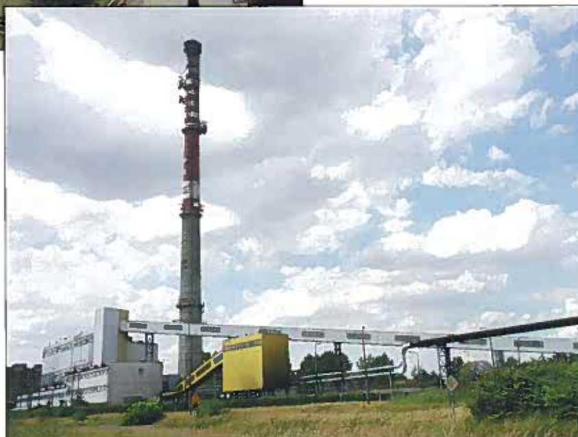
Ciepłownia Rejtan (należąca do Fortum Częstochowa SA)
