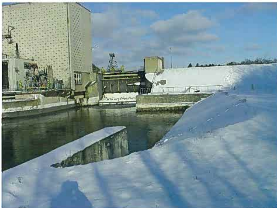
Elektrownia Wodna Trzyczyn
