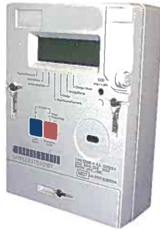
Inteligentne liczniki energii od urządzeń pomiarowych powszechnie znanych różnią się także wyglądem. Źródło: Energy Retail Association.
